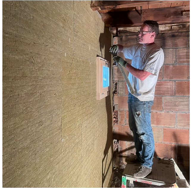
Die Aussenwand mit Fenster wird neu isoliert.
