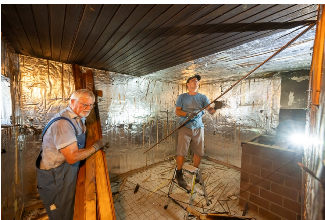
Rückbau der alten Sauna durch Vereinsmitglieder.
