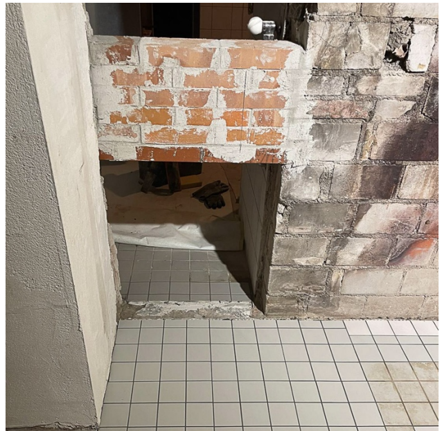
Der Bereich des Ofens, wo die Mauer erneuert und der Boden neu geplättelt werden musste.
