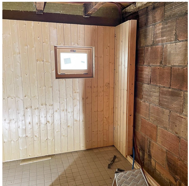
Einbau der vorgefertigten Elemente.
