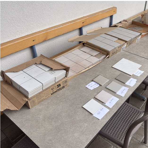
Für die Ergänzung von Plättli konnten alte Bestände aus dem Estrich verwendet werden.
