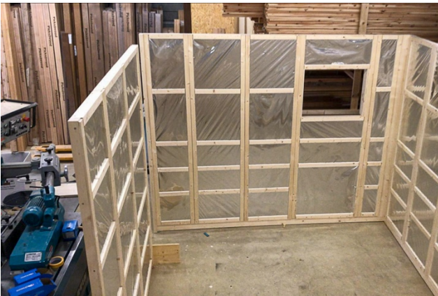
Tragekonstruktion in Werkstatt von Ging Sauna.
