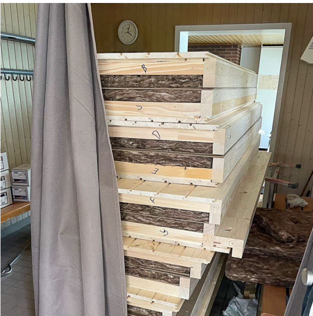
Die fertiggestellten Elemente der Sauna sind parat.
